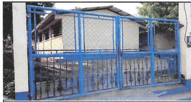
Foto 6: Porton de ingreso
