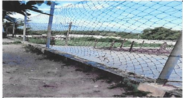
Foto 4: Malla muro perimetral
