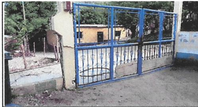
Foto 5: Porton de ingreso
