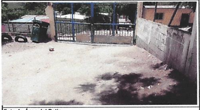
Foto 4: Área del Patio
