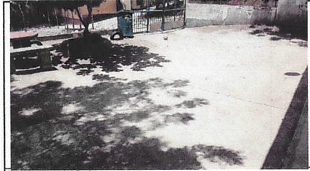
Foto 3: Área del Patio
