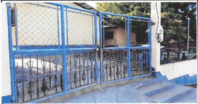
Foto 1: Porton por fuera
