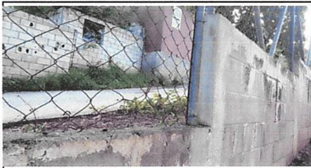
Foto 3: Malla muro perimetral
